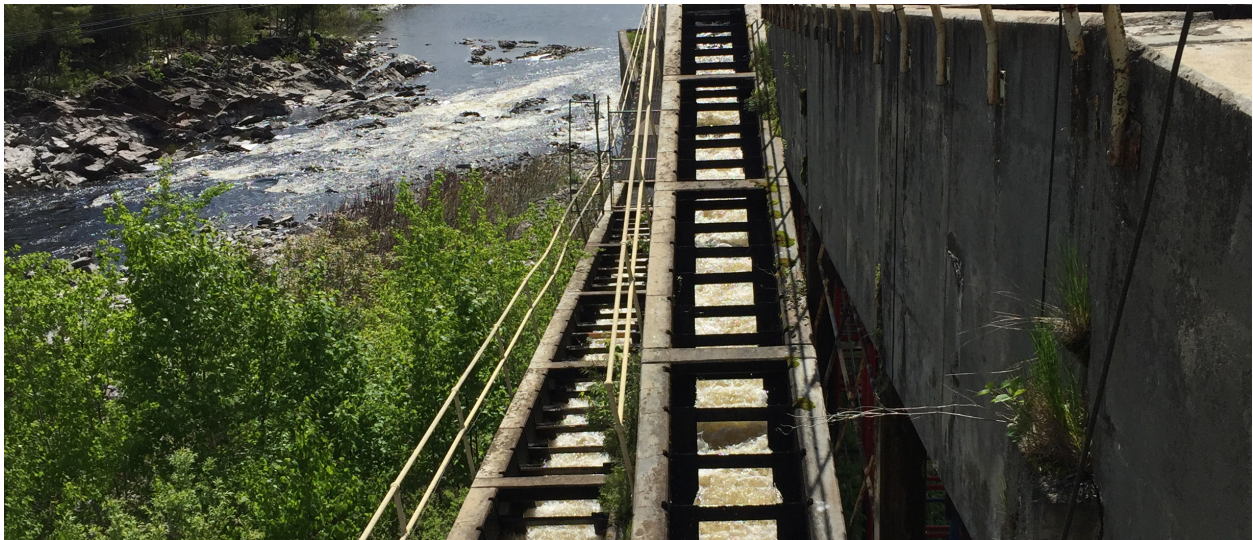
Figure 4 : Passe migratoire Denil du barrage Woodland de Baileyville (Maine), sur la rivière Sainte-Croix. Avec ses 745 pieds (227 mètres), la passe migratoire Denil du barrage Woodland est l'une des plus longues du genre au monde. Le barrage a été construit en 1965. Après plus de 50 ans de détérioration et face au désir de disposer d'une passe migratoire plus efficace, il a été décidé d'entreprendre une étude sous l'égide de l'IIBH dont l'objet était d'envisager les améliorations à apporter en amont et en aval de la passe, dans la rivière Sainte-Croix, notamment à hauteur du barrage Woodland.
