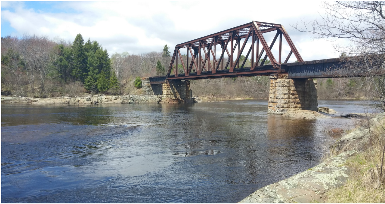
Figure 2 : Pont de chemin de fer enjambant la rivière Mississagi près de Blind River (Ontario) - Mai 2016
